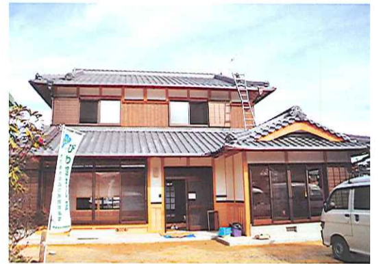
在来軸組工法で建築された住宅（甲賀市）
